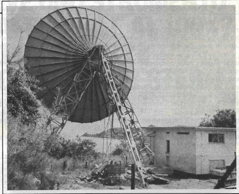
Fig. 2 - Una delle tante stazioni sperimentali allestite dall'industria per sperimentare la riflessione troposferica. Si tratta di una postazione Marconi, installata dalle parti del Lago Vittoria.
